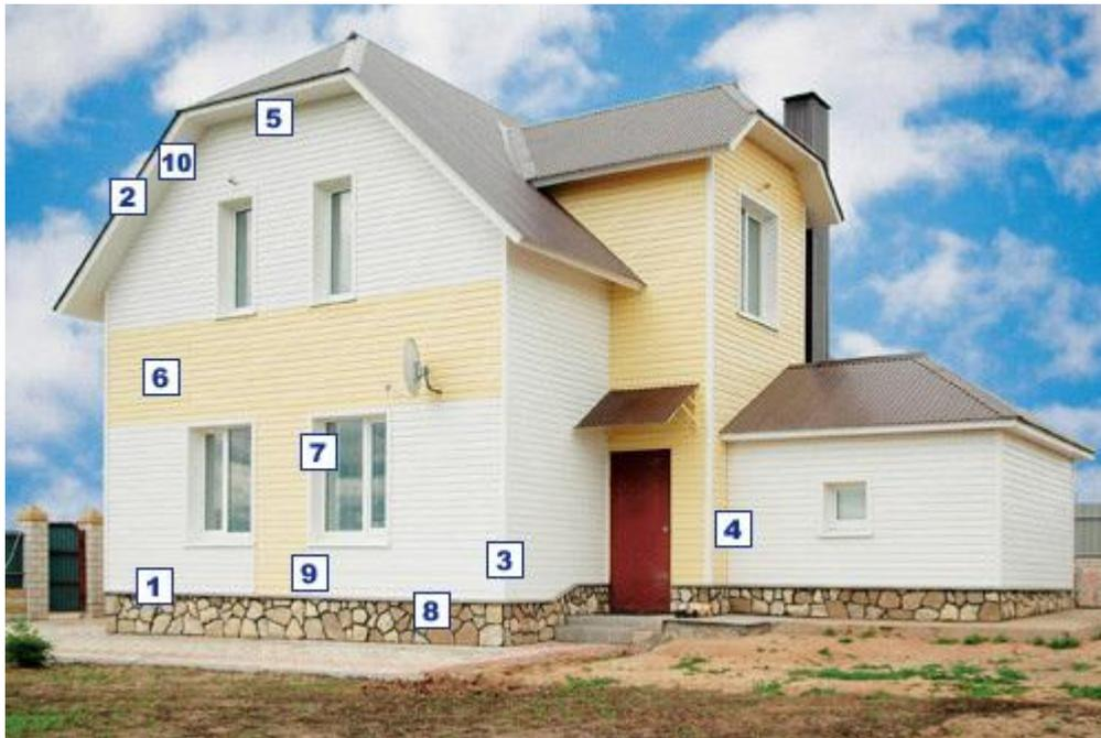
1. Стартовый профиль. Используется для крепления нижнего ряда панелей винилового сайдинга. После окончания монтажа становится невидимым, т.к. закрывается сверху ближайшим рядом панелей.
