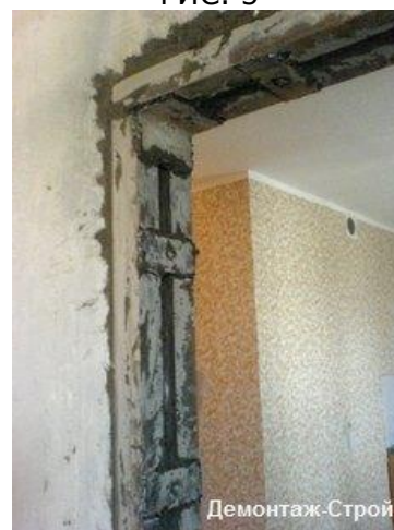
Укрепление уголком РИС. 5
