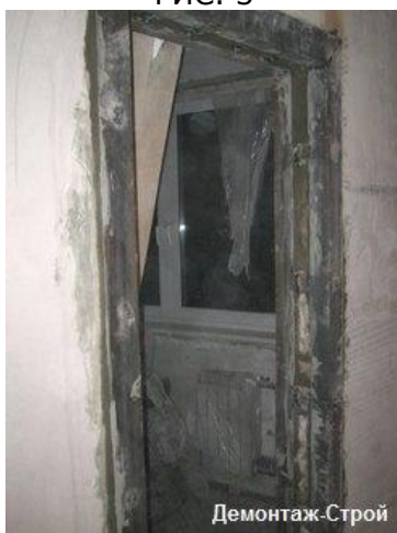
Усиление из уголка РИС. 3
