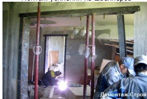
Монтаж усиления Монтаж усиления из швеллеров
