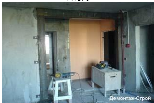
Демонтаж стены с усилением РИС. 9
