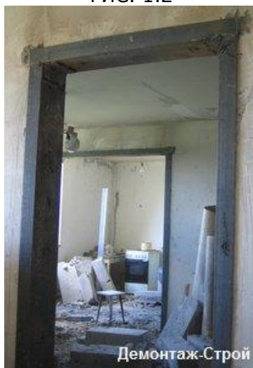
Укрепление из швеллеров "ТИП 1" (Рис. 1.1, 1.2)
