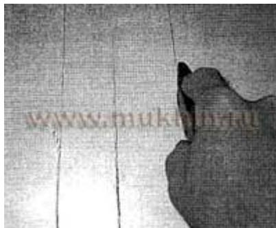
При помощи узкого шпателя или стамески удалите старую армировочную ленту и шпатлевку.
