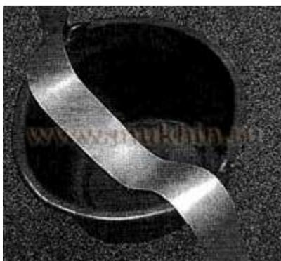
Поместите армировочную ленту на шпатлевку, покрывающую шов. Слегка придержите ленту руками. Старайтесь, чтобы ее середина приходилась на линию шва. Обмакните шпатель в воду и плотно вдавите ленту в слой шпатлевки.
