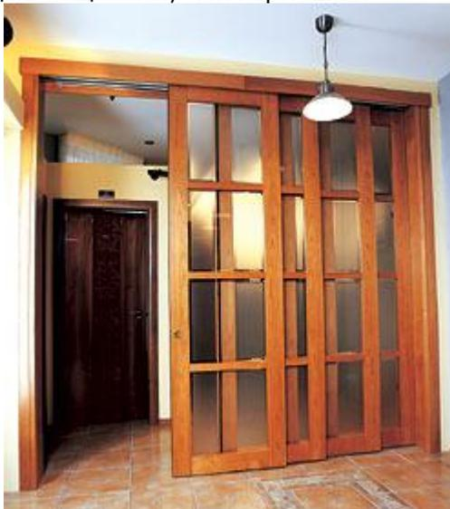
Эта конструкция позволяет как убирать полностью перегородку, оставляя открытый проем, так и приоткрывать ее на необходимую ширину. Такие перегородки крепятся к потолку, а на пол устанавливается флажок, который входит в паз полотна и не дает полотну качаться (это относится к раздвижным полотнам).
