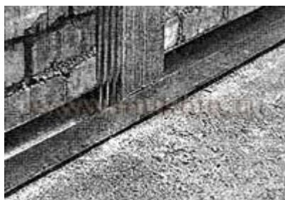
Загните вокруг стоечных профилей концы прямого подвеса и, проверяя вертикальность с помощью уровня, соедините полки профиля с подвесом шурупами-саморезами. Повторите эти
