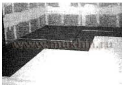
Монтаж элементов пола ведется от стены с дверным проемом. У элементов пола, примыкающих к стенам, фальц в области сопряжения обрезается. Каждый новый ряд начинается с укладки отрезанной по месту части последнего элемента предыдущего ряда, что исключает отходы и обеспечивает смещение торцевых стыков в соседних рядах (не менее 250 мм). Стыки с обрезанными фальцами не допускаются.
