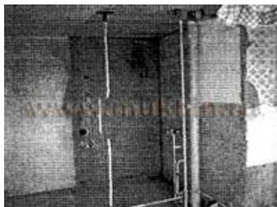
Следующий этап работ — разметка и установка направляющих и стоечных профилей с шириной полки не менее 50 мм и с шагом стоек 600 мм. Как это делается, рассказано здесь [«Монтаж перегородок из гипсокартона»](#). Однако тяжелое сантехническое оборудование нуждается в особом креплении, поэтому на стадии сборки каркаса к вертикальным стоечным профилям монтируются закладные элементы (металлические планки).
