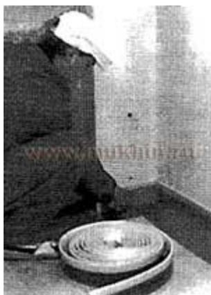
Раскрой листов ГВЛ по фактическим размерам помещения проводится с учетом зазора на кромочную ленту. Если утеплитель засыпной, его просто высыпают на пол и выравнивают рейкой по выставленным с помощью уровня маякам (например, стоечным профилям), начиная от стены, противоположной входу. При толщине более 50 мм и в местах примыканий к монолитному полу засыпку надо уплотнить.
