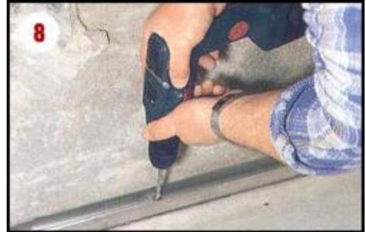
8. - Закрепив временно направляющие профили вдоль линии разметки на полу, сделайте в нем с помощью твердосплавного сверла отверстия под дюбели.
