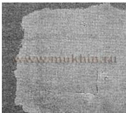
Нанесите тонкий накрывочный слой шпатлевки с помощью шпателя шириной 150 или 250 мм. Дайте шпатлевке застыть в течение 24 часов.
