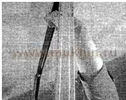
Шаг крепления направляющих металлических профилей каркасов к полу и потолку, а также стоек, примыкающих к стенам или колоннам, не более 1000 мм, но не менее трех креплений на один профиль. Крайние крепежные дюбели должны монтироваться не дальше 500 мм от конца профиля.
