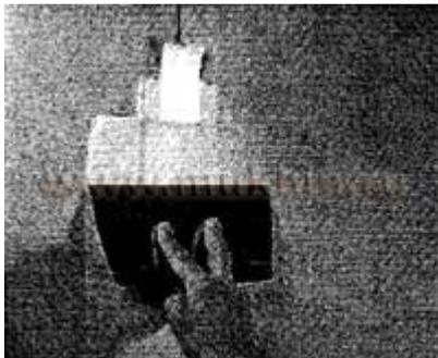
Оставшейся шпатлевкой еще раз заделайте шурупы, выравнивая просевшую после высыхания шпатлевку. Неизрасходованный материал следует выбросить, а инструмент вымыть.
