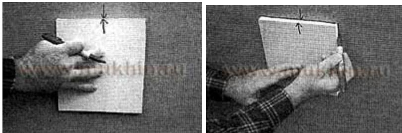
С помощью универсального ножа или универсальной пилы вырежьте в листе отверстие по обведенному контуру заготовки.
