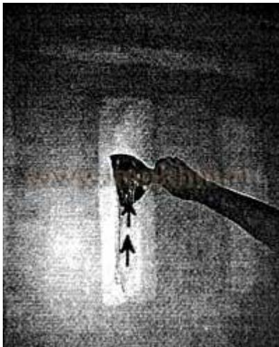
Добравшись до вершины, возьмите вправо, одновременно усиливая давление на левый угол шпателя, сводя слой шпатлевки на нет.
