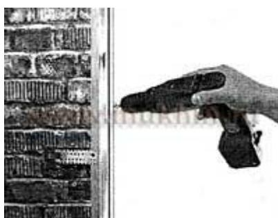
Обычно монтаж гипсокартонных листов на стоечные профили осуществляется по направлению открытой их части. Шурупы-саморезы сначала вворачиваются в полку профиля вблизи спинки и лишь потом — у противоположного края. При обратном порядке полка профиля может загнуться внутрь.
