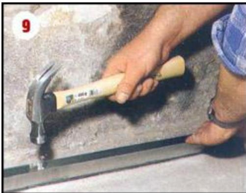
9. - Прикрепите к полу направляющие профили с помощью дюбелей и шурупов.
