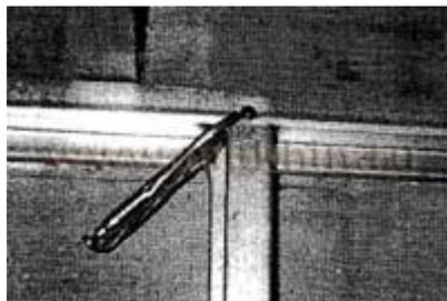
После того как все профили каркаса подогнаны и установлены, выполните разводку необходимых коммуникаций (труб, электропроводки и т.д.), используя специальные отверстия в спинках стоечных профилей.
