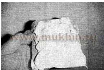
Вставьте пробку в отверстие и погрузите лоскут лицевого картона по краю заплатки в шпатлевку, нанесенную по краям отверстия. Убедитесь, что установленная заплатка находится вровень с поверхностью ремонтируемого листа гипсокартона.
