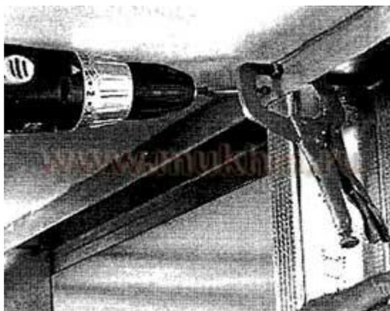
Стойки каркаса, примыкающие к стенам или колоннам, крепятся дюбель-гвоздями с требуемым шагом (не более 1000 мм, но не менее трех креплений на один профиль). Крайние крепежные дюбель-гвозди должны устанавливаться не дальше 500 мм от конца профиля.
