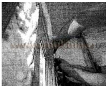
Осталось установить и закрепить гипсокартонные листы с другой стороны каркаса. Здесь важно следующее: вертикальные швы между гипсокартонными листами смещают на один шаг стоечных профилей (600 мм) по отношению к обшивке первой стороны. Таким образом, монтаж начинается с неполного листа гипсокартона.
