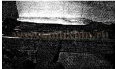
Небольшие впадинки, оставшиеся после шпатлевания, заполнятся при нанесении последующих слоев. После того как шпатлевка высохнет, угол будет выглядеть примерно так.
