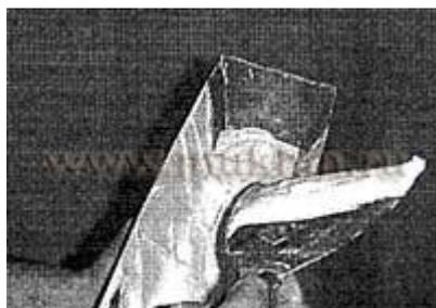
Начинайте шпатлевать с потолка. Нанесите смесь шпателем на стык и промажьте его продольными движениями так, чтобы ширина полосы была немного шире армировочной ленты. Вдавливайте шпатлевку в щель. Следите, чтобы вся поверхность, на которую будет ложиться лента, была покрыта тонким слоем шпатлевки. Не беда, если слой в некоторых местах окажется несколько толще, — при последующих манипуляциях излишек массы уберется.
