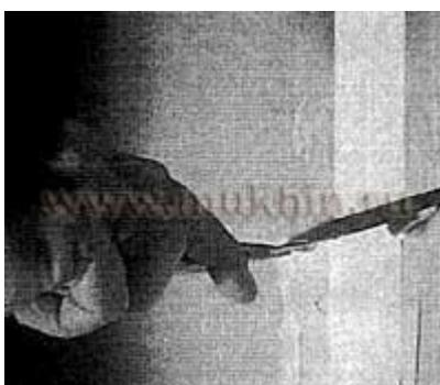
Пока вы работаете, держите шпатель чистым, периодически соскабливая с него шпатлевочную массу о край ванночки. Шпатлевка, остающаяся на шпателе, пересыхает. Оставшуюся после обработки швов армировочной лентой шпатлевку используйте для заделки шурупов, после чего неизрасходованную массу придется выбросить. Не забудьте вымыть инструменты. Полученная после армирования швов поверхность должна выглядеть примерно так. Время для просушки — 24 часа.
