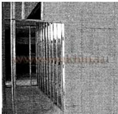
На следующем этапе производится укладка в пространство между стоечными профилями изоляционного материала. Изоляция должна плотно заполнить промежуток между профилями и не должна сползать.
