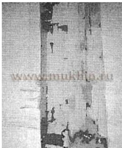
С помощью шпателя шириной 100 мм нанесите тонкий слой шпатлевки вокруг поврежденного участка. Вдавите армировочную ленту в шпатлевку с помощью шпателя шириной 100 мм. Разровняйте шпатлевку с помощью шпателя шириной 150 мм и дайте ей просохнуть в течение 24 часов. Далее действуйте по технологии, описанной в разделе «Шпатлевка гипсокартона».
