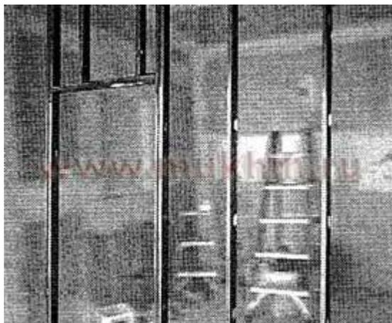
Электрические провода пропускаются через изолированные вставками отверстия в стенках стоечных профилей перпендикулярно к ним. Еще раз напоминаем: не допускается проводка кабелей внутри вдоль стоечных профилей каркаса, во избежание повреждения шурупами при монтаже ГКЛ.
