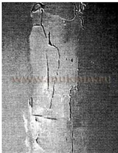
Обратите внимание: при работе шпатель рекомендуется смачивать водой — так легче наносить смесь. Еще одна тонкость: подготовленный кусок армировочной бумажной ленты надо быстро пропустить через ведро с водой, чтобы она увлажнилась. Это делается для лучшей адгезии со шпатлевкой.
