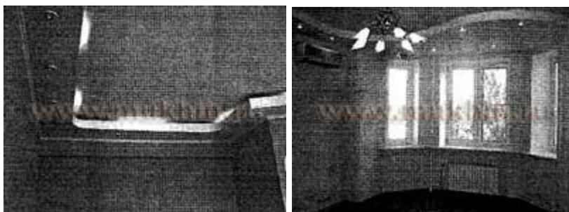
Небольшой подвесной потолок по периметру помещения с криволинейной боковой поверхностью, с овальной или круглой нишей в центре потолка, — вот идеальное решение для выполнения нестандартного подвесного потолка в типовых квартирах.
