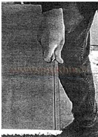
Остается добавить, что однородная, достаточно плотная структура гипсокартонного листа позволяет производить качественную резку при помощи ножовки или электролобзика. Скорее всего, ножовкой вы воспользуетесь при вырезании небольших фрагментов под окно, дверной проем и т.д. Но даже в этом случае из двух линий разреза только одна будет обработана ножовкой, а вторую удобнее резать ножом.
