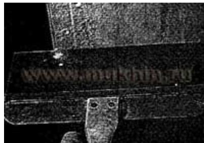
Нанесите второй слой шпатлевки, захватывая уже по 150 мм с каждой стороны угла. Удобнее использовать 100-миллиметровый шпатель.
