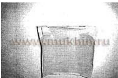
С помощью 100-миллиметрового шпателя нанесите тонкий слой шпатлевки вокруг отверстия на поверхность гипсокартона, внутрь отверстия и по краям заплатки-пробки.
