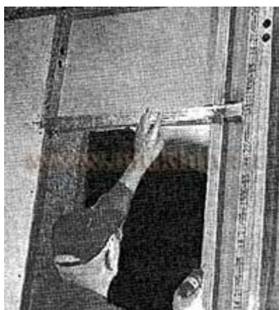
Шов гипсокартонных плит не должен располагаться на стойках, к которым прикрепляется дверная коробка. Место их соединения всегда должно находиться на промежуточной стойке, устанавливаемой над горизонтальной балкой.
