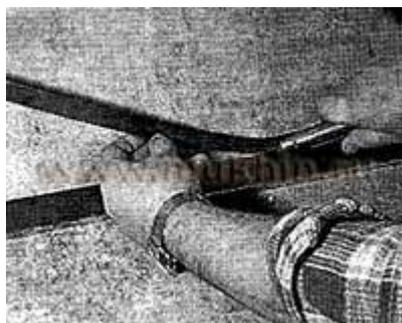
Теперь надо временно закрепить направляющие профили вдоль линий разметки на полу и на потолке и просверлить в них отверстия для дюбелей. При необходимости это можно сделать не через отверстия в направляющих, а непосредственно через стенки профилей в нужных точках.
