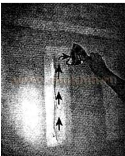
Теперь разверните ваше запястье и прогладьте шпателем нанесенный слой шпатлевки сверху вниз. На лезвии шпателя соберется некоторое количество шпатлевочной массы, — и вот вы готовы к обработке следующего ряда. Если шпатлевка загустеет, счищайте ее в ванночку и перемешивайте смесь. Когда и в ванночке масса станет гуще, чем нужно для удобной работы, верните ее в ведро с разведенной шпатлевкой и наберите свежей.
