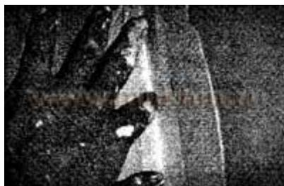
Увлажните шпатель и выровняйте сначала одну сторону угла, затем другую. Ведите шпатель сверху вниз, придерживайте ленту за верхний конец. Усилие должно быть достаточным для того, чтобы из-под ленты выдавились излишки шпатлевки. Здесь важно не повредить ленту, работая шпателем, ведь он должен пройти как можно ближе к линии сгиба. Но, в общем-то, эта процедура аналогична заделке армировочной ленты на ровных участках, и вы уже понимаете, что должно получиться на выходе.
