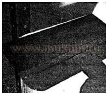
Нанесите шпатлевку 250-миллиметровым шпателем полосой сверху вниз, захватывая от края угла приблизительно 100—130 мм в каждую сторону. Не делайте первый слой слишком тонким.
